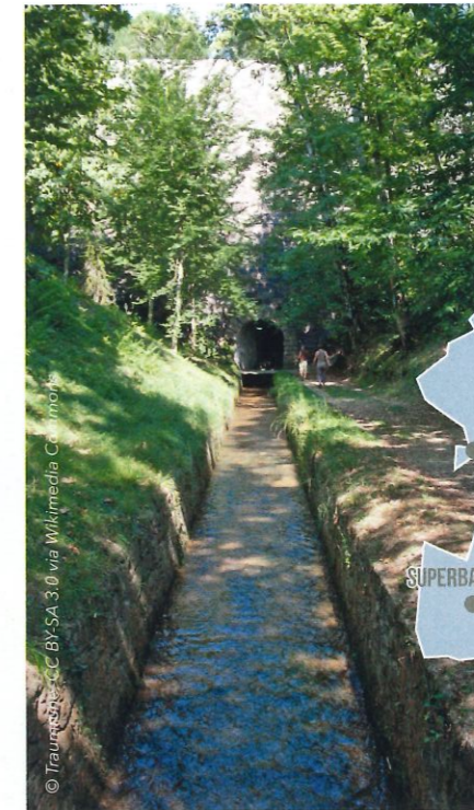
Sortie d'eau au barrage du lac Saint-Ferréol.
